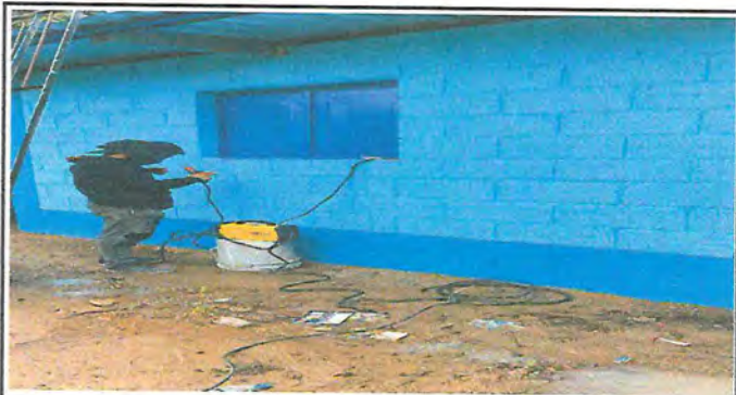
Foto 4: Colocacion de ventana en la cocina
