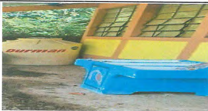
Foto 3: Instalación de nueva pila en proceso.
