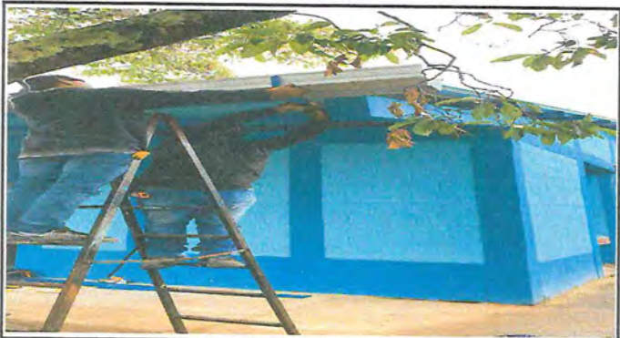
Foto 3: Colocacion de canales.
