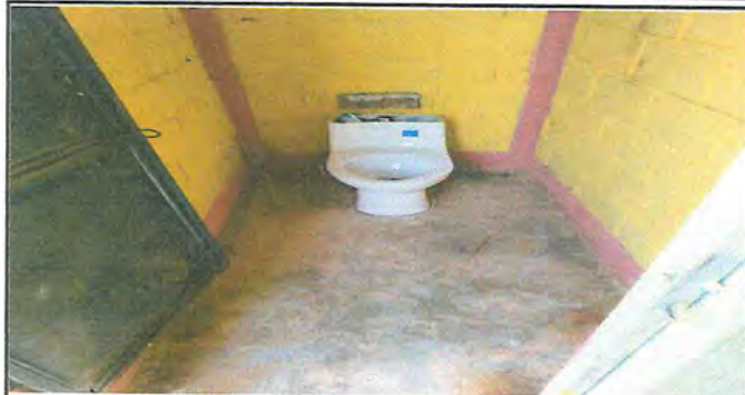
Foto 2: Sustitución de sanitarios en proceso.
