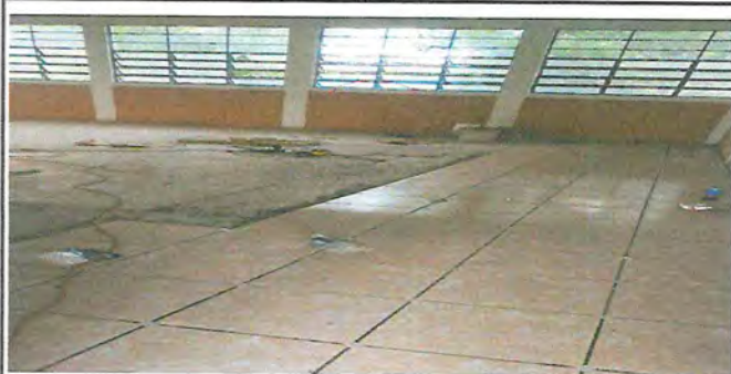
Foto 5: Aulas ya en proceso de sustitución de piso cerámico.
