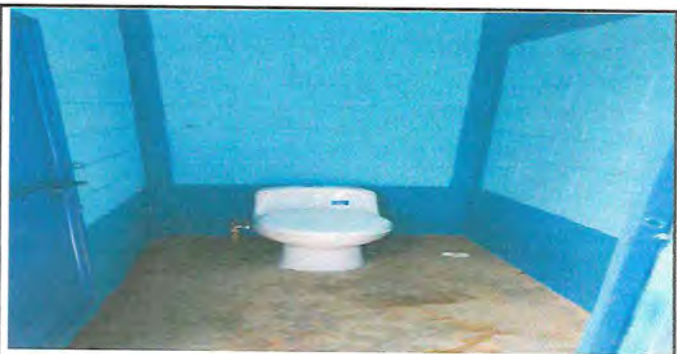
Foto 6: Mantenimiento de puertas de baños.
