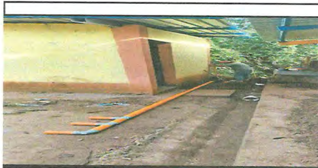
Foto 6: Tubería de aguas pluviales en proceso
